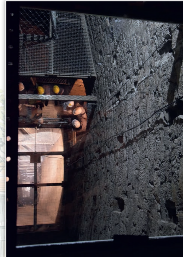
Blick in den Schacht nach der Sanierung 2020
